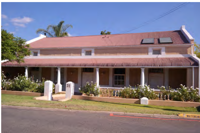
Photo 37. H7 - Voortrekker Street - Intact Veranda House
